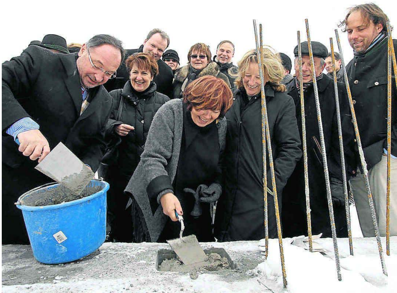
Mit vereinten Kräften betonierten Bürgermeisterin Brigitte Servatius und Landrat Karl Roth den Grundstein ein. Zu diesem "besonderen Moment" waren Verbandsräte, Schulleiter, Geschäftsleiterin Eva John und Christian Merk vom Architekturbüro Köhler gekommen. Foto: fkn, Andrea Jaksch
